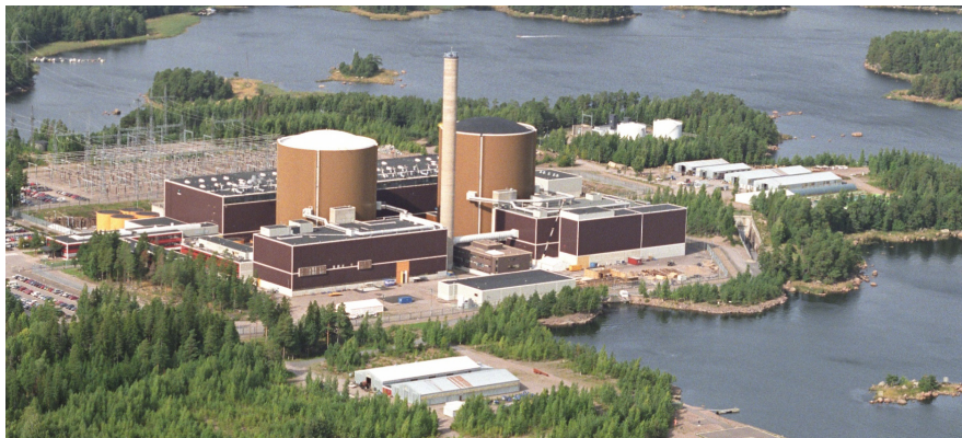
Kuva: Fortum Power and Heat Oy
