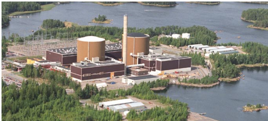
Kuva: Fortum Power and Heat Oy
