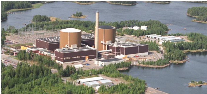
Kuva: Fortum Power and Heat Oy
