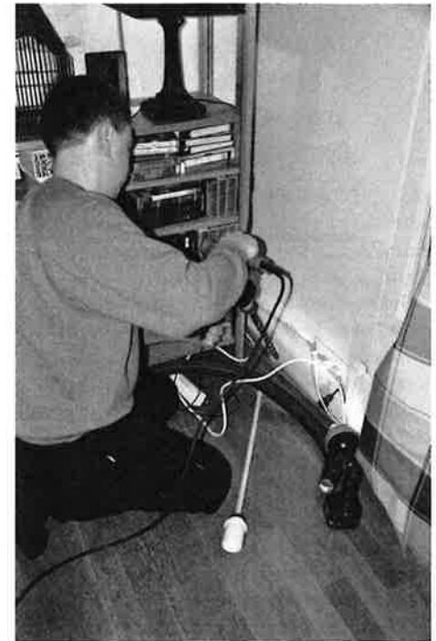
Rakennusmateriaalista otetun näytteen avulla voidaan todeta mikrobikasvu materiaalisissa ja varmistaa vaurion esiintyminen sekä saada lisätietoa vaurion laajuudesta tai syvyydestä rakennekerroksissa.
