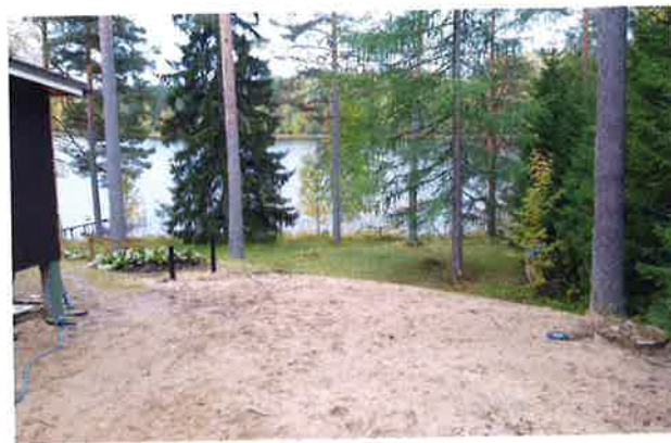
Kuva 2. Vapaa-ajan asunnolle tehdyssä jätevesiremontissa asennettiin umpisäiliö mustille jätevesille ja maasuodattamo harmaille jätevesille. Kuva: Ari Kauppinen
