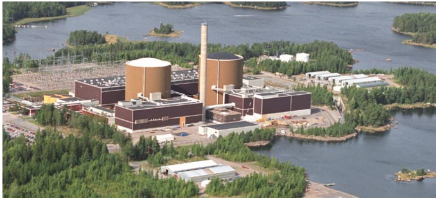
Kuva: Fortum Power and Heat Oy
