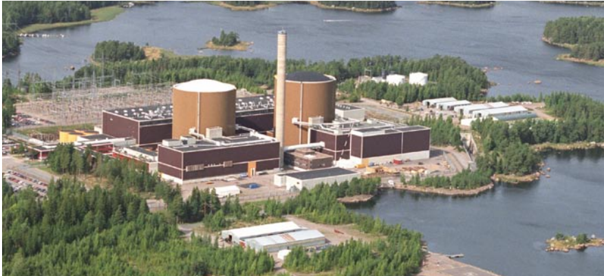
Kuva: Fortum Power and Heat Oy
