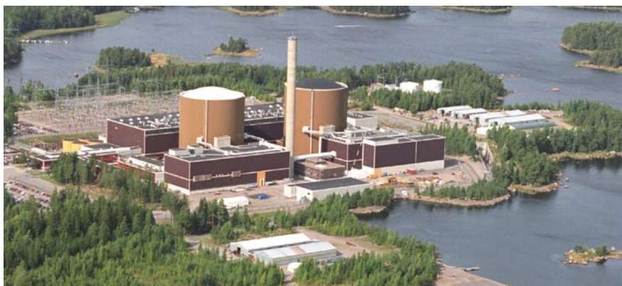
Kuva: Fortum Power and Heat Oy
