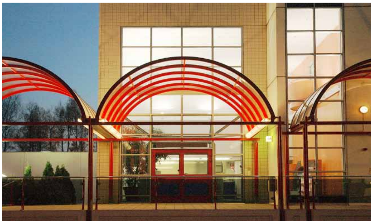
Säteilyturvakeskuksen toimitalon pääsisäänkäynti
