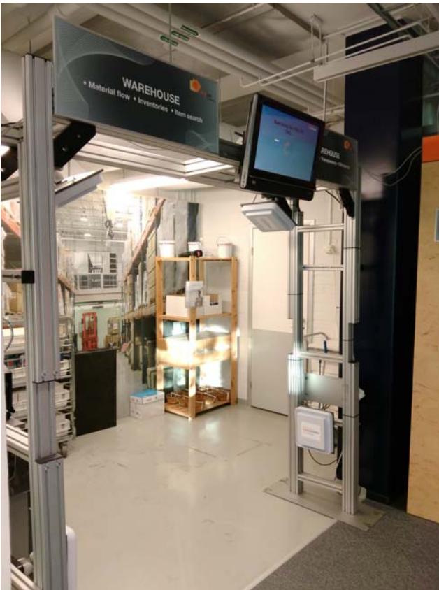
Kuva 3. RFID-lukijan antennit asennettuina porttiin. (Kuva: RFID Lab Finland ry.)
