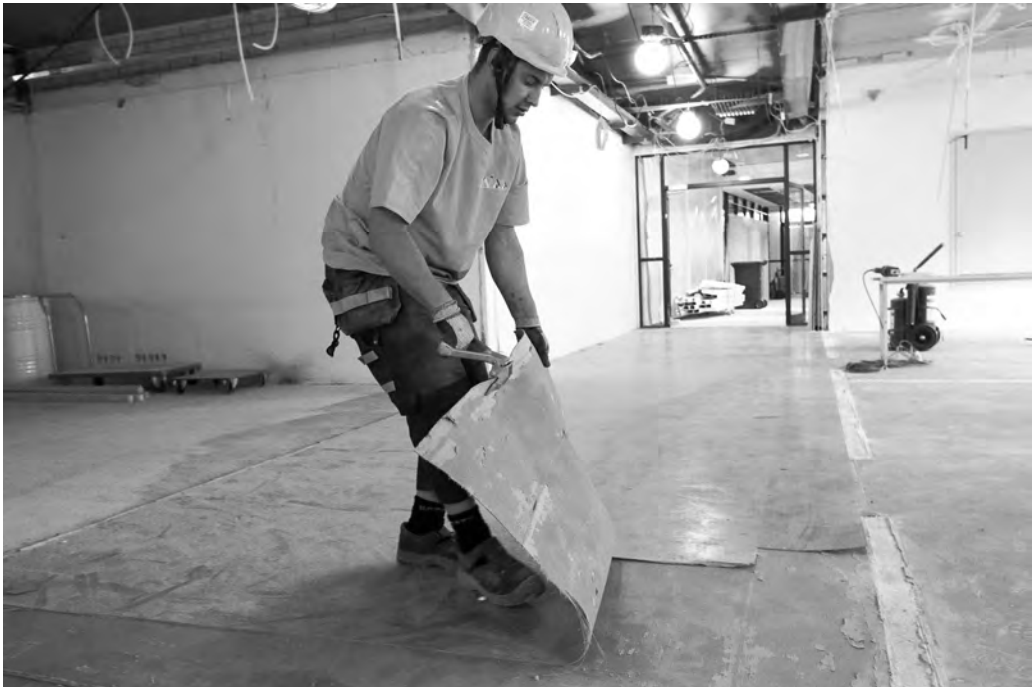
Kuva 3. Rakennusliikkeen työntekijä poistaa vanhaa muovimattoa. Kuvan henkilö ei ole kumpikaan hankkeen mittauspäivänä mattoja poistaneista rakennusmiehistä, mutta muuten työkohde, työnkuva ja suojautuminen ovat vastaavat. Valokuva: Simo Porras, Työterveyslaitos, 2015.
