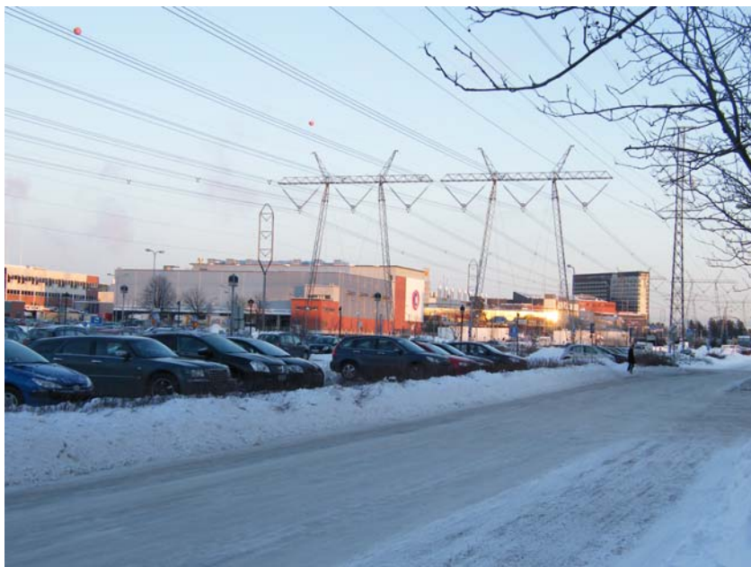
Kuva 12. 400 kV:n sähkösiirtolinja kauppakeskus Jumbon kohdalla Vantaalla.
