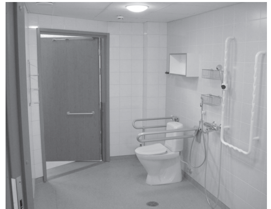
Kuva 23.28. Kokonaisia tiloja voidaan mallintaa, kun halutaan testata toiminnan sujuvuutta ennen kalliin rakennuksen rakentamista. Kuvissa on varusteineen täydellisen toimivaksi rakennettu potilashuoneen malli, jonka avulla testataan kaikkia potilaan käsittely- ja hoitovaiheita ja niissä tarvittavaa tekniikkaa. Ikkunan paikalla on valokuva sairaalan ulkonäkymästä.
