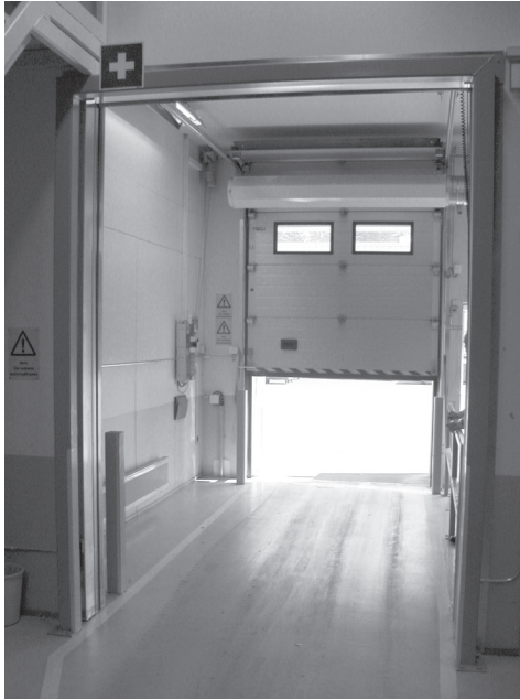
Kuva 9.5. Kylmän ilman kulkeutumista avoimien ovien kautta sisätiloihin voidaan estää ilma-verhoilla, lamelliverhoilla tai kuvan mukaisella trukki liikenteen tuulikaapilla. Turvallisuuden takia trukkitien vieressä (kuvan ulkopuolella) on oma ovi henkilöliikenteelle.
