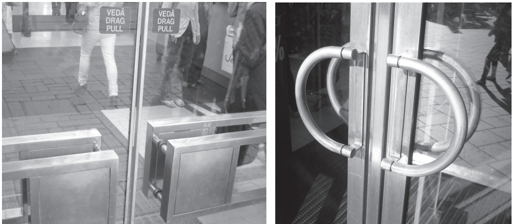
Kuva 16.6. Levymäinen ovenkahva (vasemmalla) vihjaa vahvasti työntämiseen – tässä on tarvittu lisäksi teipattuna tieto oikeasta avautumissuunnasta. Tankomainen vetokahva (oikealla) vihjaa selvemmin vetämiseen, eikä lisäinformaatiota tarvita.
