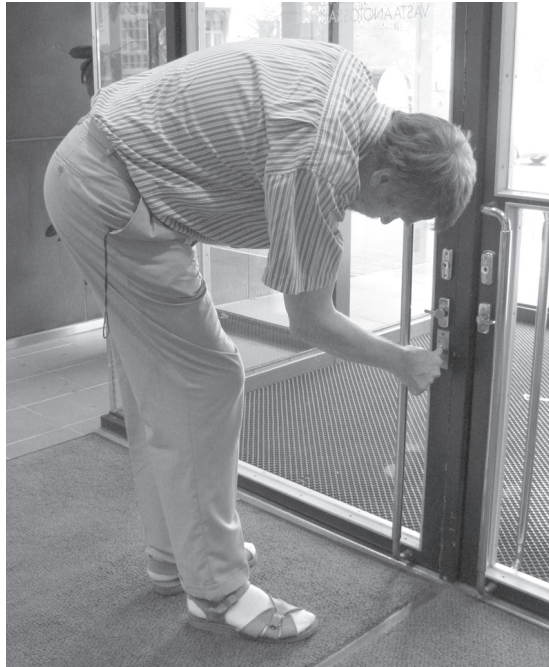
Kuva 3.1. Ihmisen mitat saattavat joskus unohtua suunnittelussa. Oven avaamisen painonappi on pyörätuolin käyttäjillekin liian matalalla.
