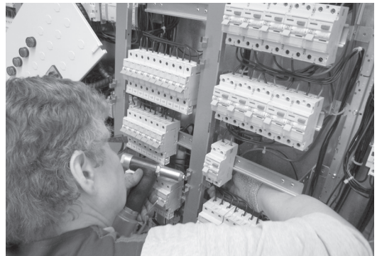
Kuva 22.6. Tuotteen kokoonpanosakin voi olla hankaluuksia, jos tuotteen suunnittelussa ei olla ajateltu kokoonpanon yhteydessä tapahtuvaa mahdollista korjailutarvetta.
