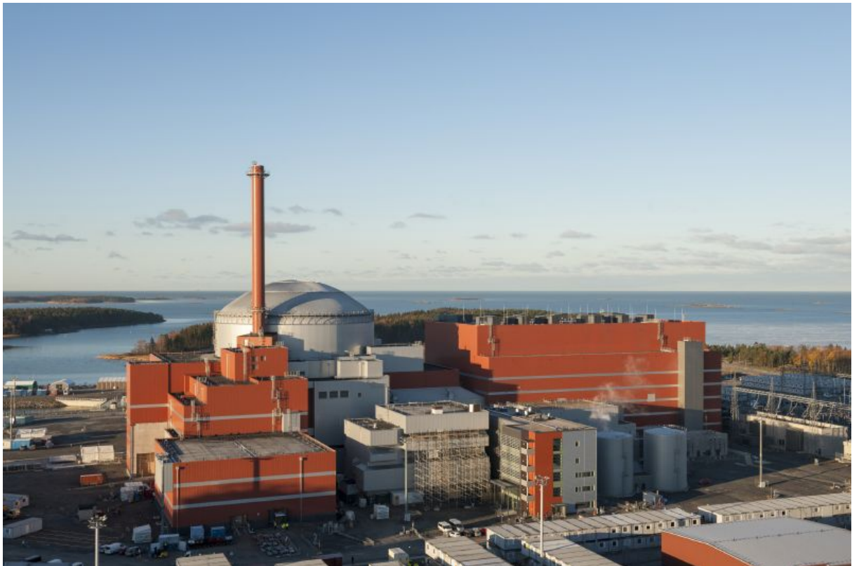
Kuva: Olkiluodon ydinvoimalaitoksen rakenteilla oleva 3-yksikkö.
